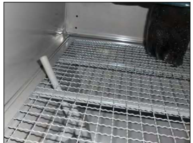
Figura 12 – Collocazione tubo metallico
